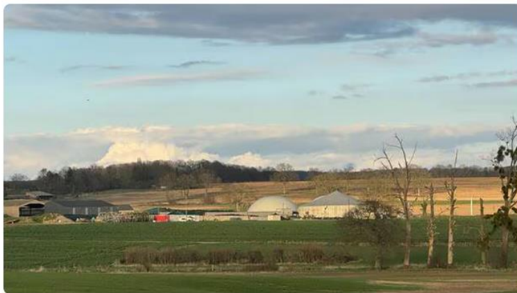
Un méthaniseur installé dans le Perche ornaï est suspecté d'être à l'origine d'une pollution d'un cours d'eau. | OUEST-FRANCE
