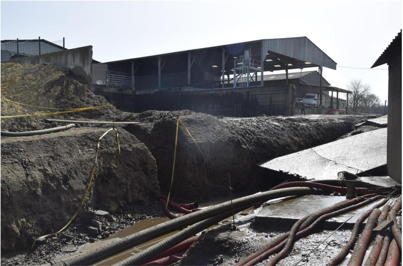
Le mur de la zone de stockage (ici à droite) a cédé, et a été propulsé par la vague de lisier à plusieurs mètres. (©Le Perche)
